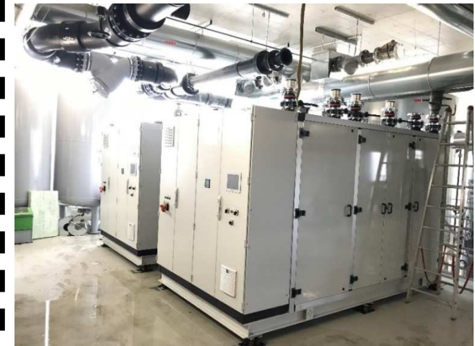
Beispiel Wärmepumpenanlage 2 x 1.000 kW
